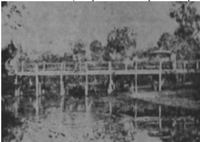
Figura 12 – Estrada carroçável que dava acesso à praia de Coqueiro
