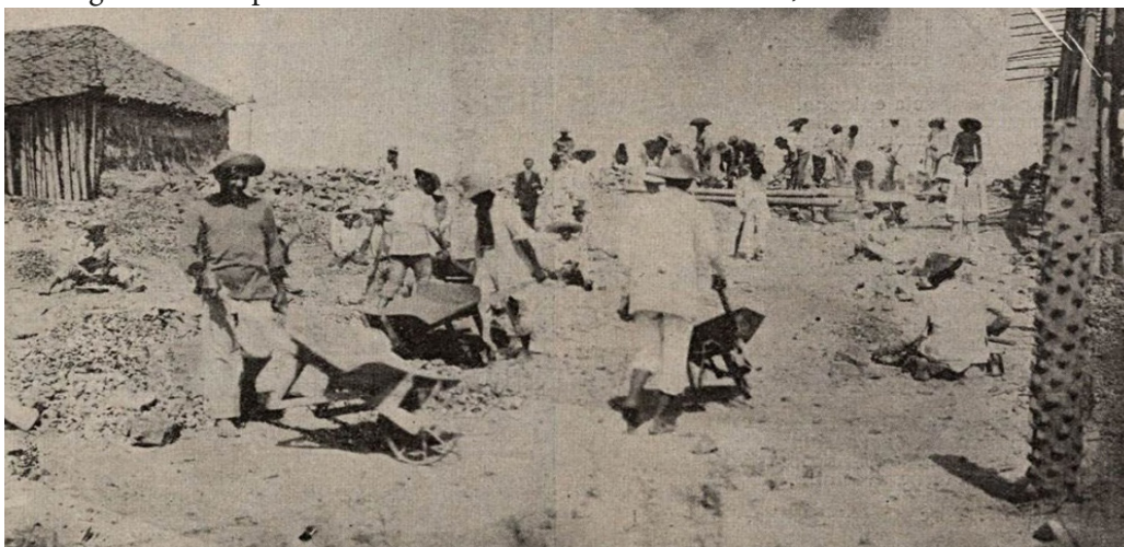
Figura 4 – “Aspecto das obras do novo cais de Parnaíba, no Estado do Piauí”.
