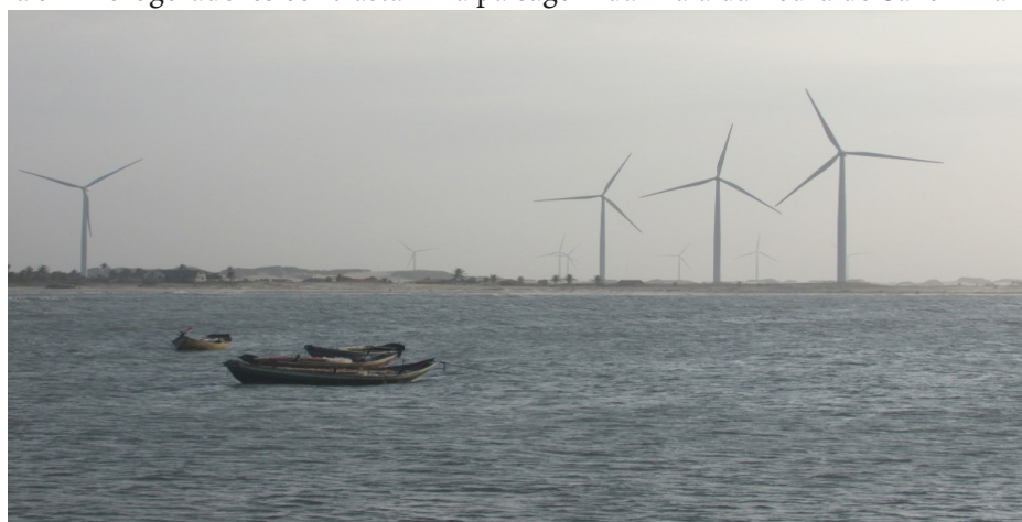
Figura 3 – Aerogeradores contrastam na paisagem da Praia da Pedra do Sal em Parnaíba.
