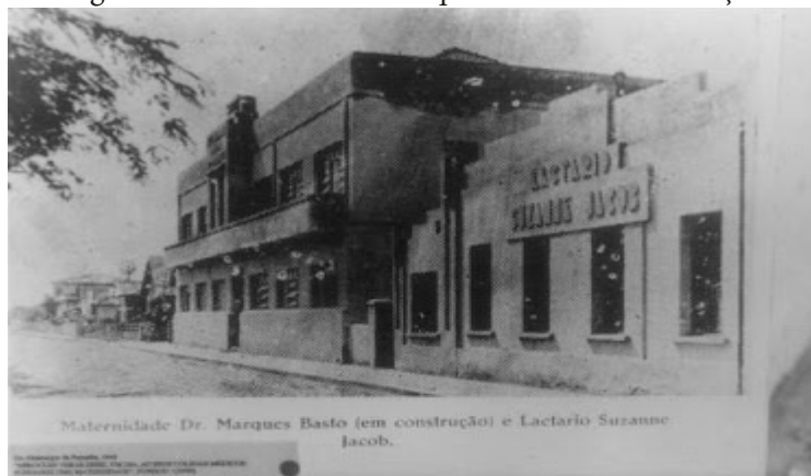
Figura 2 – Maternidade Marques Basto em construção
